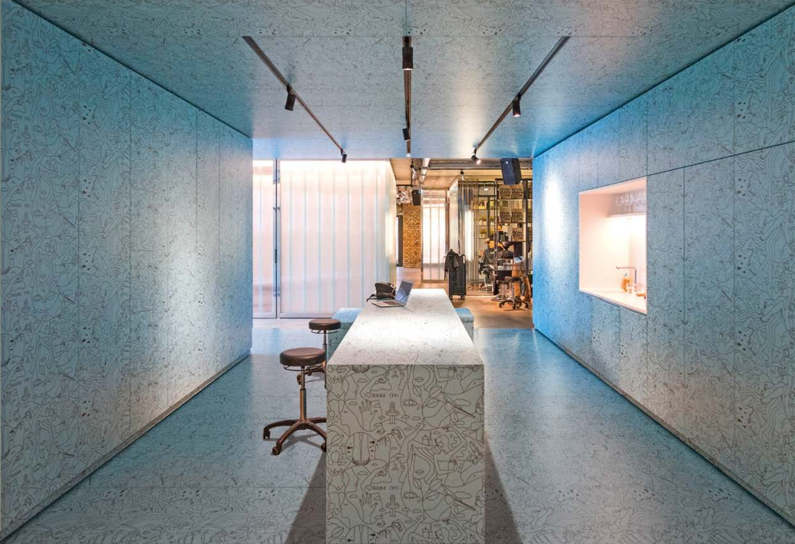
Bild 1: Boden-, Wand- und Deckengestaltung mit HPL
