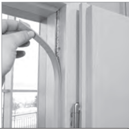
Zargendichtung bandseitig ablösen
